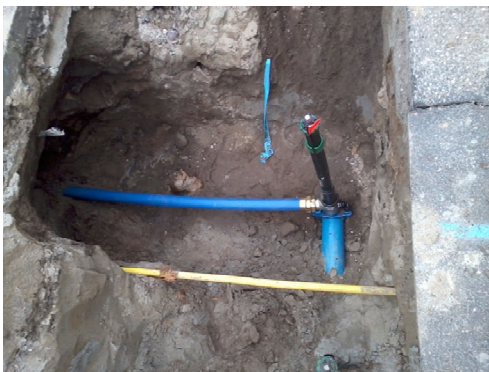
Bilder: Erneuerungen Hausanschluss und Hydrant
