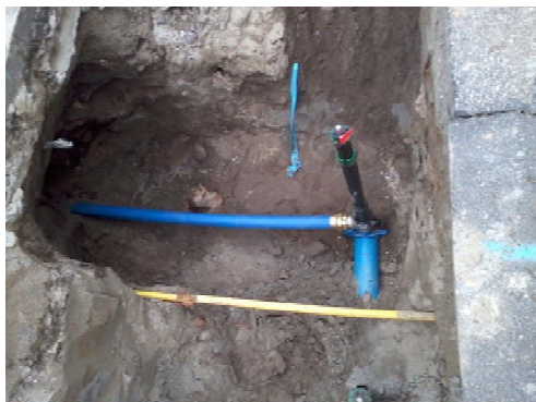
Bilder: Erneuerungen Hausanschluss und Hydrant
