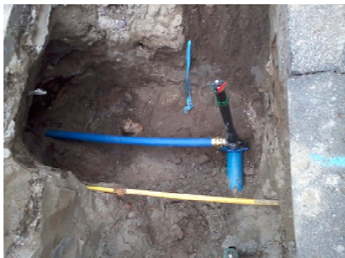
Bilder: Erneuerungen Hausanschluss und Hydrant
