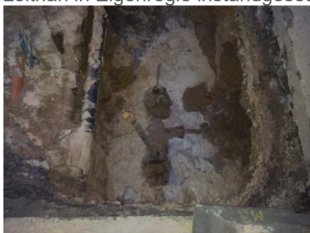
Bilder: Rohrbruch mit Scherbenbruch
