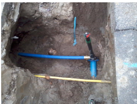
Bilder: Erneuerungen Hausanschluss und Hydrant
